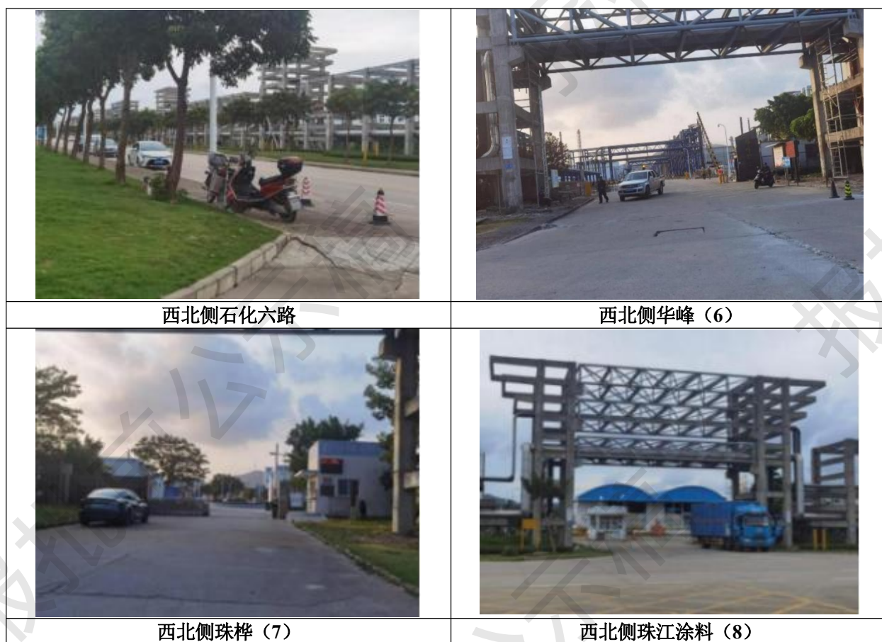
图 3.1-2 厂区四至照片
